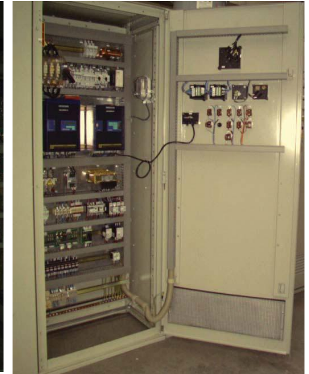
Esempio di azionamenti CC prima e dopo il revamping (Immagine di AiC). fonte: http://www.aicnet.it/media-download/case-history/best-practices-to-implement-complete-revamping-of-obsolete-plants-idc8.html
