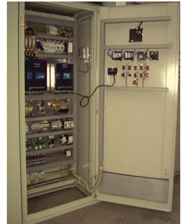
Esempio di azionamenti CC prima e dopo il revamping (Immagine di AiC). Fonte: http://www.aicnet.it/media-download/case-history/best-practices-to-implementation-complete-revamping-of-obsolete-plants-idc8.html
