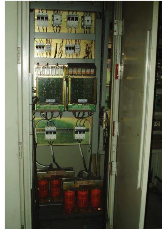
Esempio di azionamenti CC prima e dopo il revamping (Immagine di AiC). fonte: http://www.aicnet.it/media-download/case-history/best-practices-to-implement-complete-revamping-of-obsolete-plants-idc8.html
